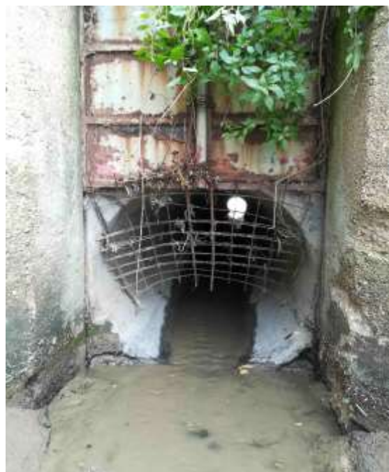
Foto 4, 5 e 6 - Griglia metallica rimessa in funzione grazie all'intervento di Picena Ambiente, tramite escavatore. Questo costituisce il principale accesso per le nutrie dal fiume Tronto.
