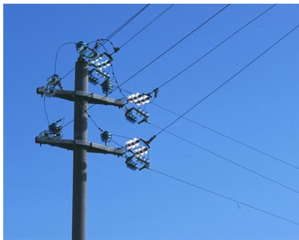
Una delle tipologie di sostegni più comuni e ad alto rischio di elettrocuzione.
